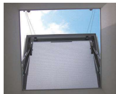
片側開閉 見上げ（開閉途中）
