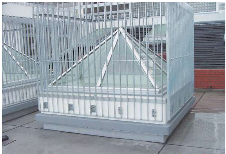
防護柵（別途）を設置した例
