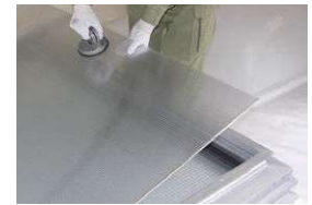
ガラスの上に中空シートを設置
