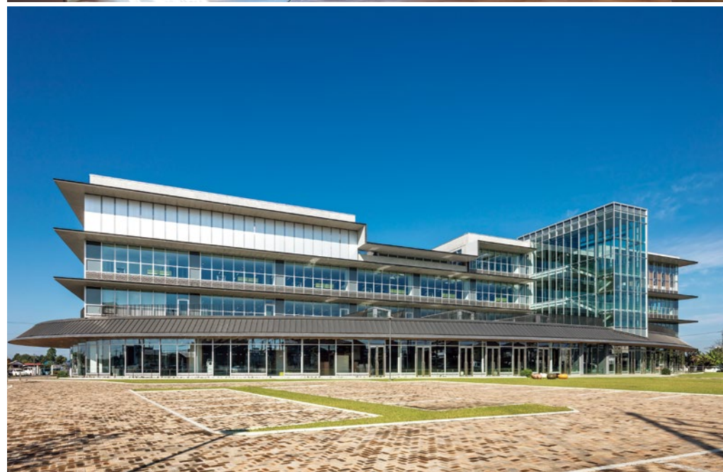
下野市役所 栃木県下野市
